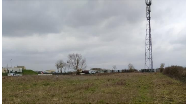
Figure 7 : Photographie de la déchetterie au nord du site d'étude
