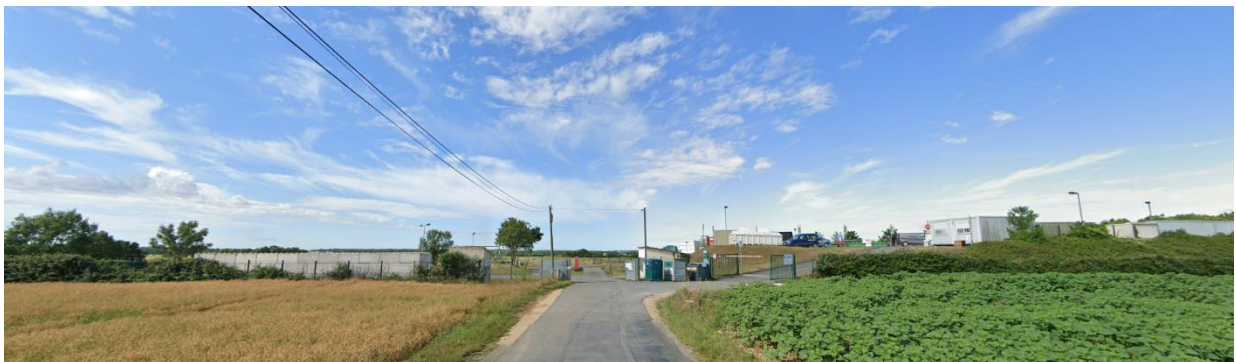
Figure 5 : Photographies de la déchetterie et de l'antenne relais
