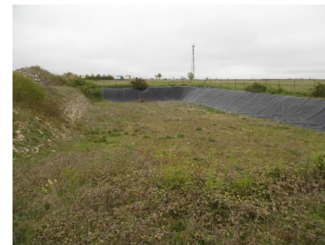
Illustration 2: Bassin de décantation à sec présent au sein de la ZIP
