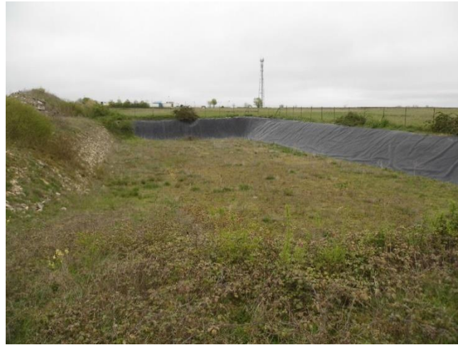
Illustration 5: Illustration d'un bassin de rétention à sec et des arbustes présents sur la ZIP
