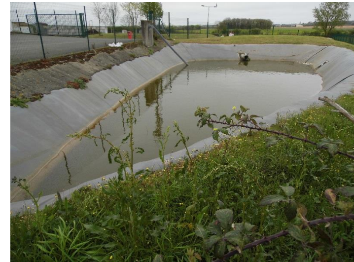
Illustration 6: Bassin de décantation à proximité de la déchetterie pouvant servir de zone de chasse
